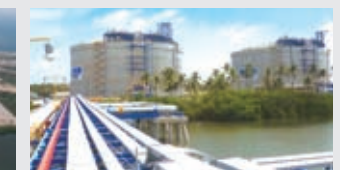
Manzanillo, Mexico LNG Terminal Project
