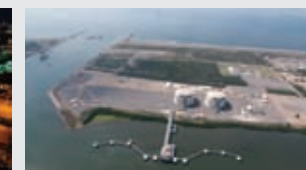
Thailand PTT LNG Terminal Project
