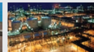
Ras Laffan, Qatar LNG Project
